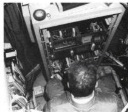
In een waterdichte behuizing (bestand tegen een druk van 35 atmosfeer) met een diameter van 1,5 meter en een hoogte van 2,3 meter zijn alle elektronische componenten van de trencher ondergebracht.
